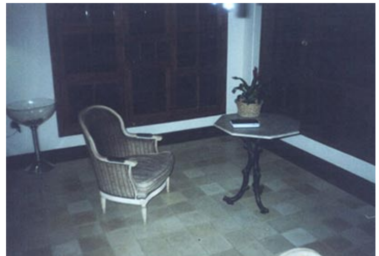
Piso de sala de visita em Ladrilho Hidráulico 20x20cm, Liso em tons de marfim, formando um patch work.
