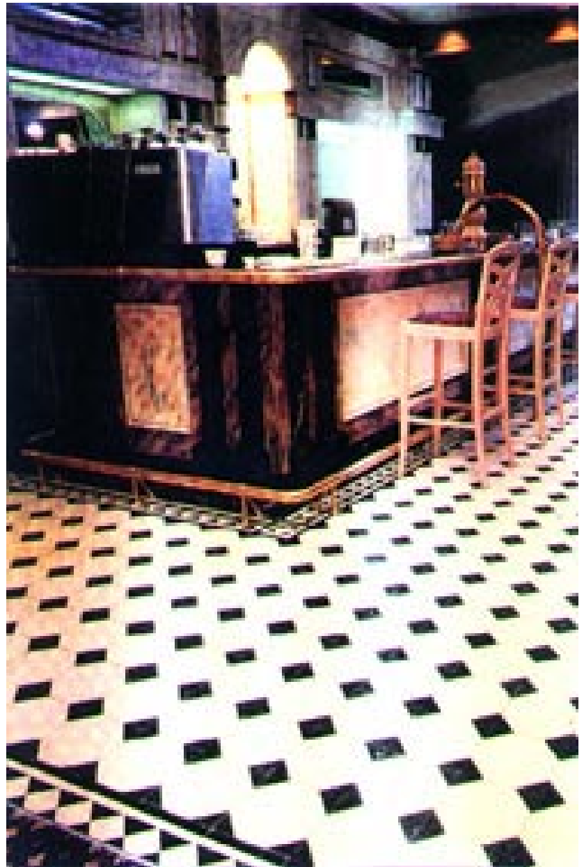
Piso de bar de um restaurante construído em Ladrilho Hidráulico Paladium Preto Onix e Branco Diamante com tabeira Grec em preto e branco.
