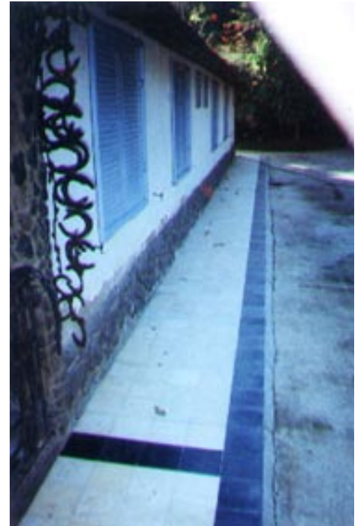
Calçadas externas construídas em Ladrilho Hidráulico de ponta de estoque, Liso 20x20cm em vários tons de brancos tendo ao redor Ladrilho Hidráulico 20x20cm na cor preto, com tratamento de baixa manutenção, com tema de piso de época, remontando um estilo antigo.
