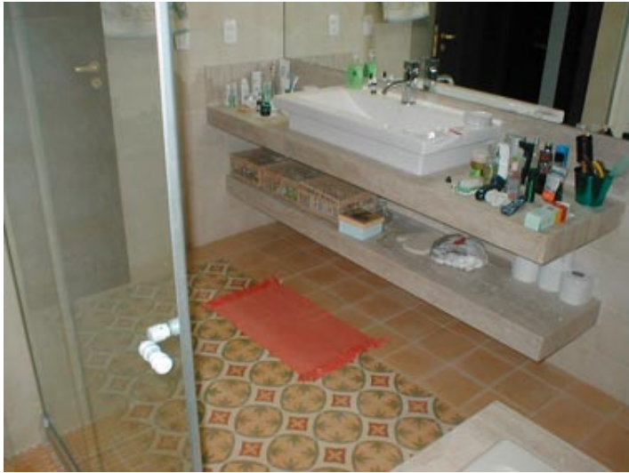
Banheiro no casal com piso em Ladrilho Hidráulico Linha Floral modelo Art Naif 20x20cm 4 cores, Amarelo Topázio nº 14, Verde desmaiado, Branco diamante e Vermelho Rubí, formando tapete central ao banheiro sendo o resto do piso em Ladrilho Hidráulico Amarelo Topázio nº 14
