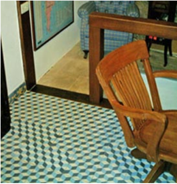
Piso em Ladrilho Hidráulico modelo Balões tridimensionais 20x20cm, linha Geométricos, 3 cores, sendo: Verde Musgo Rústico nº 44, Marfim nº 33, Azul Água Marinha, nº 15.
