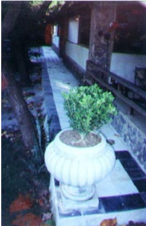
Calçadas externas construídas em Ladrilho Hidráulico de ponta de estoque, Liso 20x20cm em vários tons de brancos tendo ao redor Ladrilho Hidráulico 20x20cm na cor preto, com tratamento de baixa manutenção, com tema de piso de época, remontando um estilo antigo.
