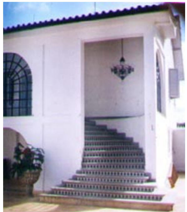
Tabeira Grec Escada confeccionada com detalhe no espelho, utilizando Tabeira Grec 20x20cm, 2 cores, fundo Branco Diamante nº 32 e quadrados Preto Ônix nº 31 embutida em degraus de granito cinza apicoado.
